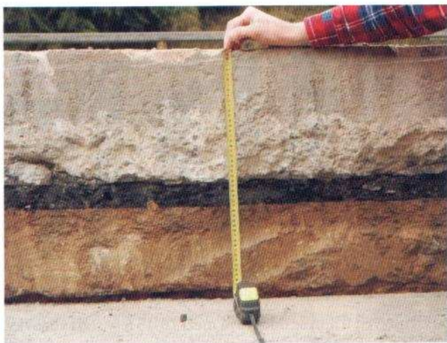
Obr. 3 Původní CBK na dálnici D1 km 34-41 (Ostředek-Šternov), uvedení do provozu 1977, demolice a foto 2017
